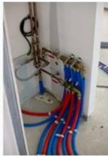
Schéma de plomberie ou chauffage avec nourrices
