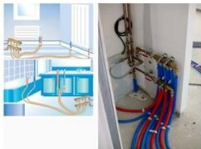
Schéma de plomberie ou chauffage avec nourrices
