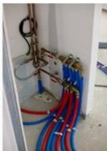
Schéma de plomberie ou chauffage avec nourrices
